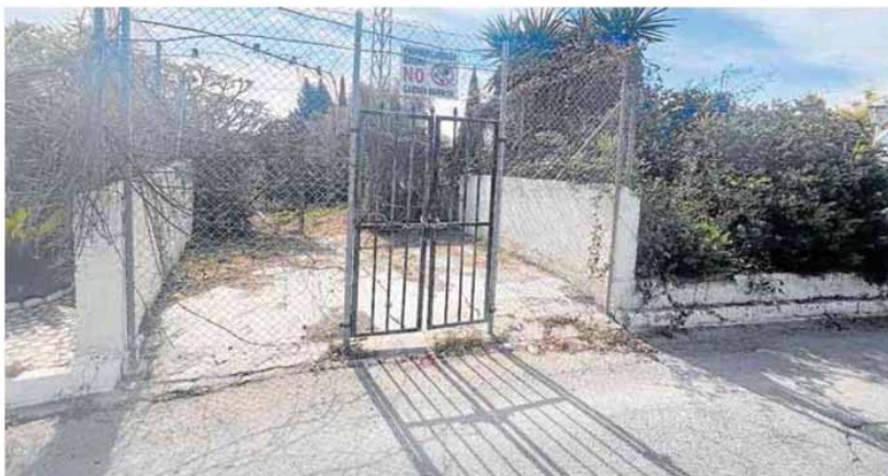
Imagen del acceso a la parcela en la que se sitúa la depuradora que va a ser suprimida. E. CABEZAS
