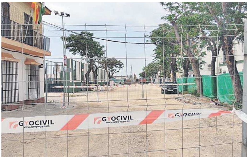
Una imagen de los trabajos del tanque de tormentas, junto a la barriada de la Playa.
