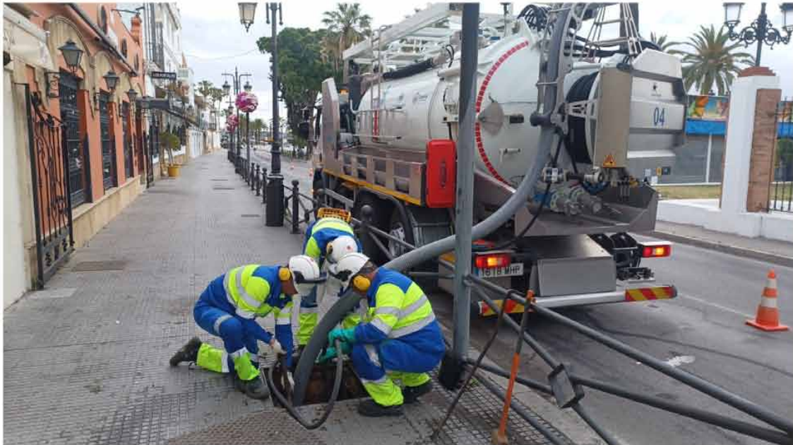
Trabajos de saneamiento en la Ribera del Marisco en El Puerto.
