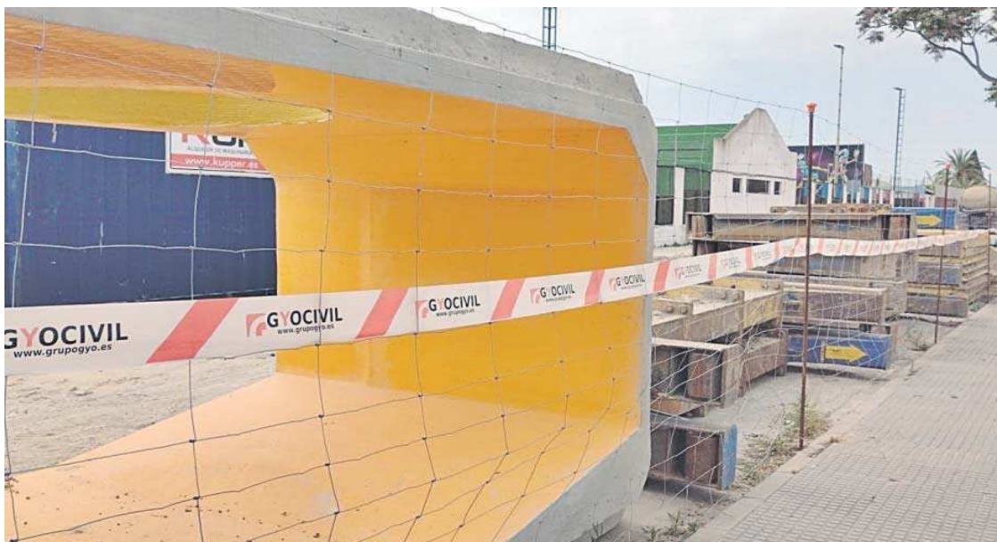
Una imagen de los trabajos del tanque de tormentas y sus conducciones, en la avenida de la Bajamar.
