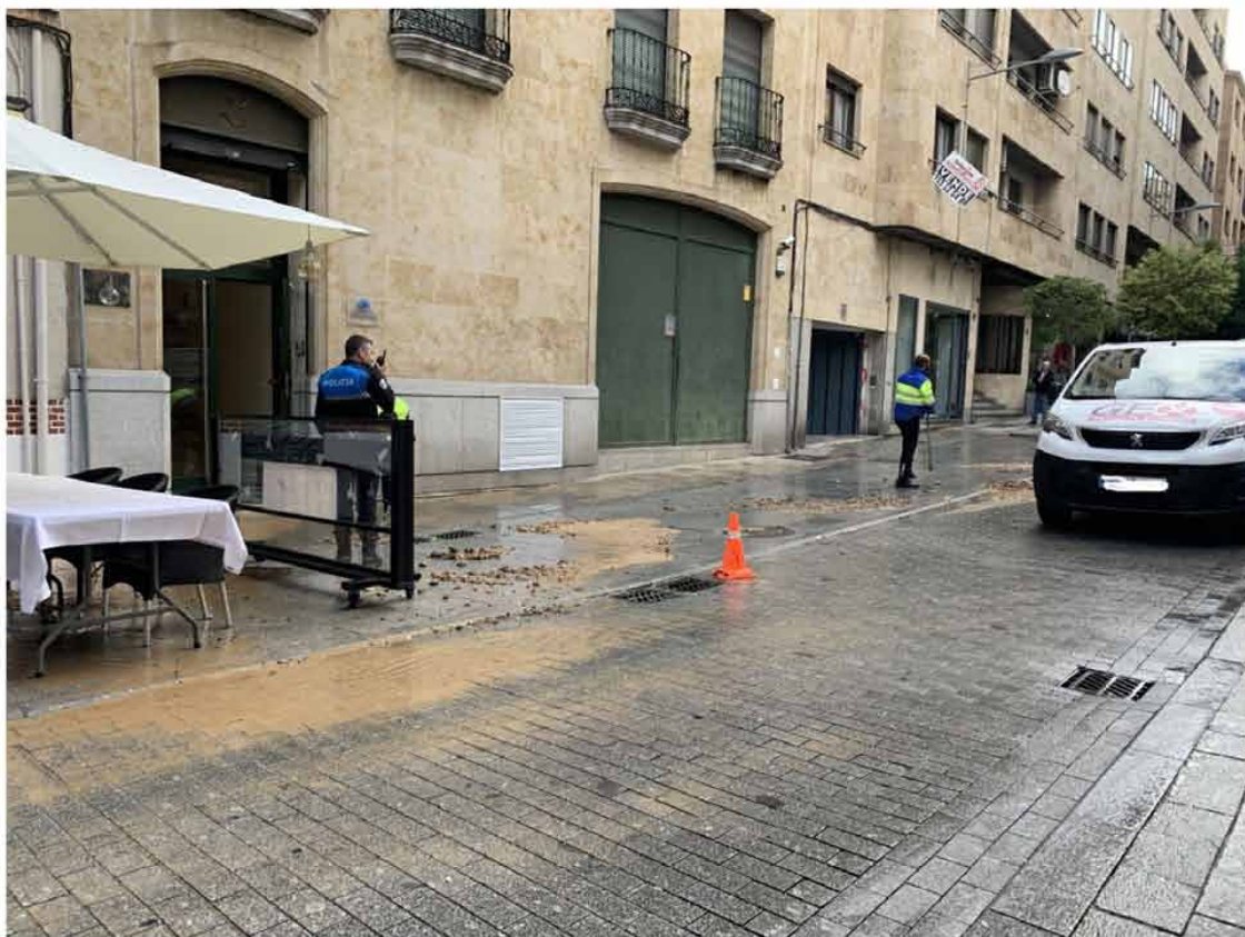
Operarios trabajan en el reventón de Pozo Amarillo.
