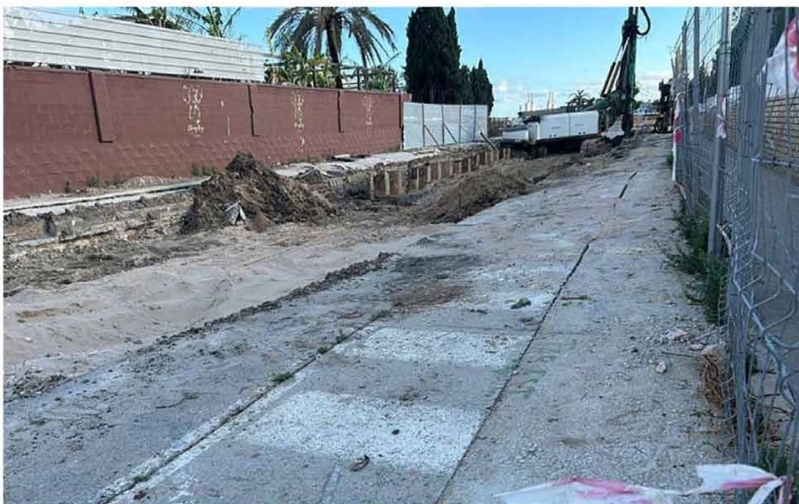
Los trabajos en marcha / FOTO: Flave
