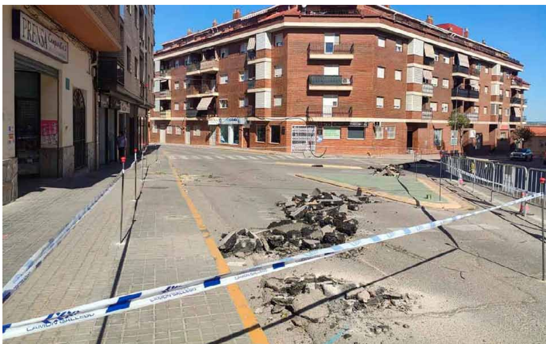
Primeras intervenciones en el tramo I de la calle Camino Batán./ Ayto. Caspe
