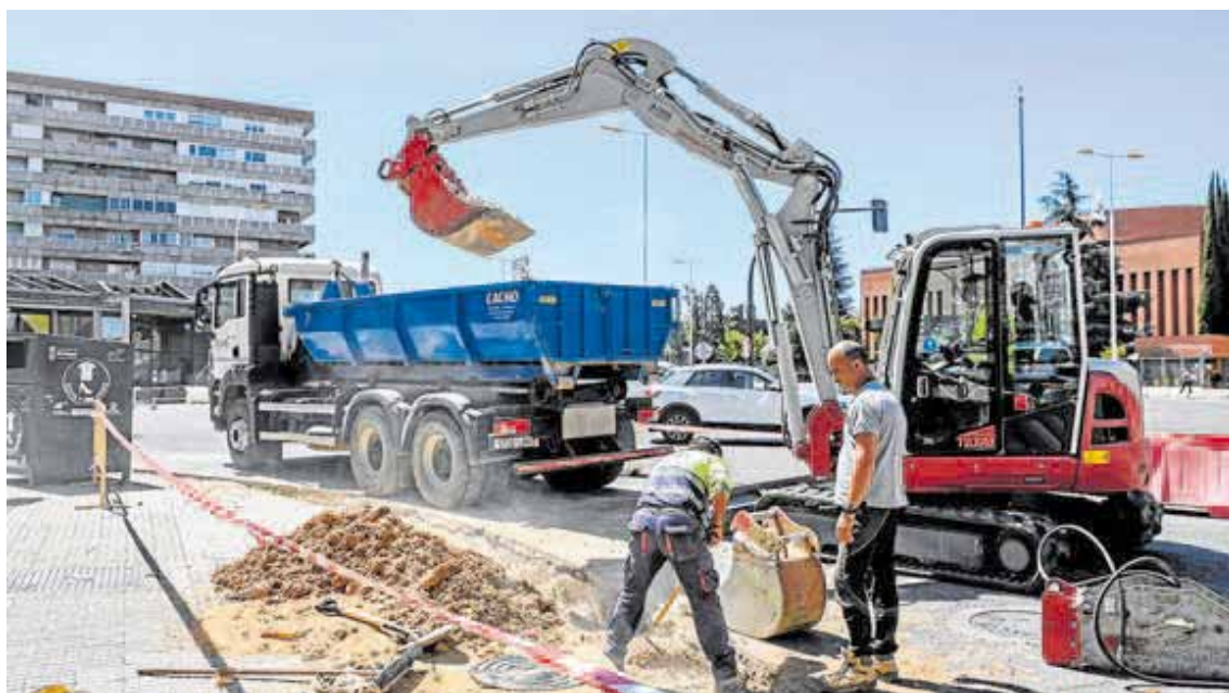
Trabajos de mejora de la red de agua en Badajoz. HOY
