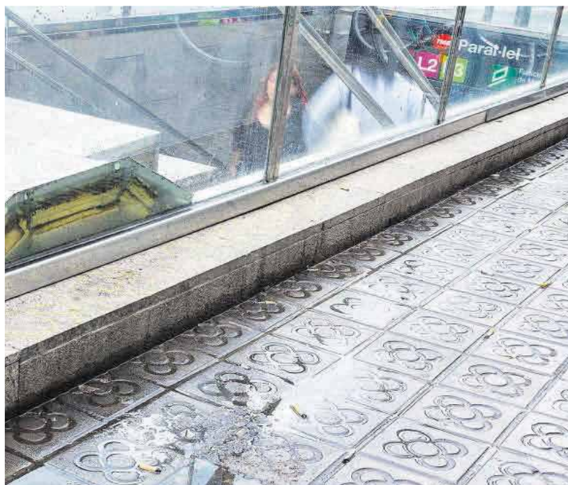
Acceso a la estación de metro de Paral·lel, en Barcelona.
